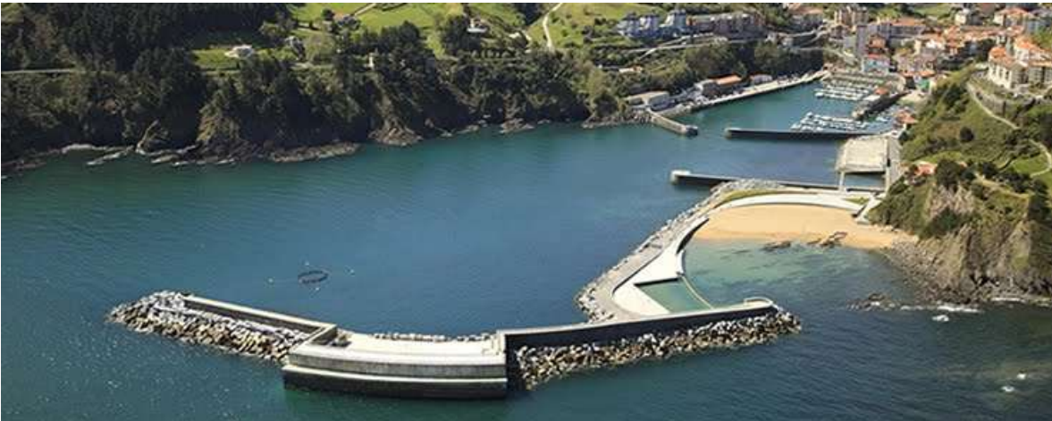
Figura 1. OWC integrada al rompeolas del puerto de Mutriku, España
